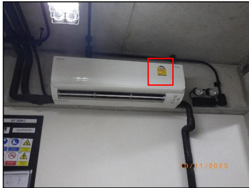
รูปที่ 2-55 ระบบปรับอากาศที่ติดตั้งภายในอาคาร ต้องมีค่าสัมประสิทธิ์สมรรถนะขั้นต่ำ ค่าประสิทธิภาพการให้ความเย็น และค่าพลังงานไฟฟ้าต่อตันความเย็นเป็นไปตามที่รัฐมนตรีประกาศกำหนด (ฉลากเบอร์ 5)
