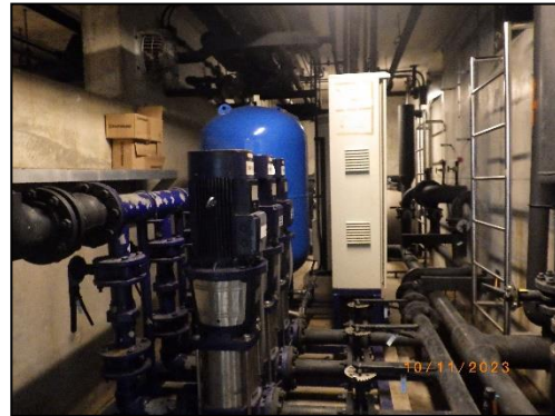
รูปที่ 2-20 ระบบสูบน้ำในอาคาร ซึ่งทำหน้าที่สูบน้ำโดยไม่มีตังน้ำเข้ามาจากท่อประปาโดยตรง และควบคุมการจ่ายน้ำด้วยระบบตั้งเวลา
