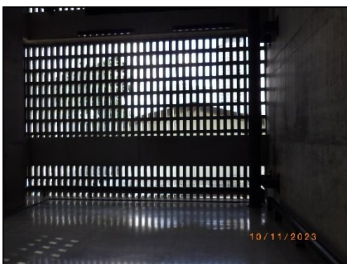
รูปที่ 2-11 จัดให้บริเวณที่จอดรถภายในอาคารระบบระบายอากาศแบบธรรมชาติ มีลักษณะเปิดโล่งไม่ปิดทึบ (1)
