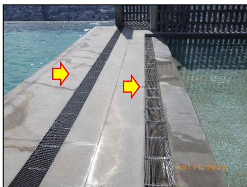
รูปที่ 2-29 รางระบายน้ำล้นมีฝาปิดรอบสระว่ายน้ำ
