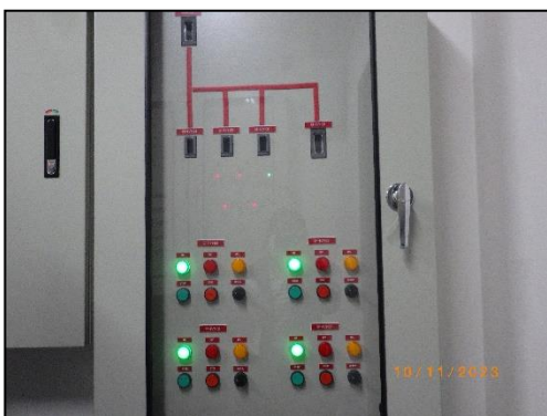
รูปที่ 2-17 ระบบมิเตอร์ไฟฟ้าสำหรับระบบบำบัดน้ำเสีย โดยเฉพาะ แยกจากระบบไฟฟ้าอื่น ๆ
